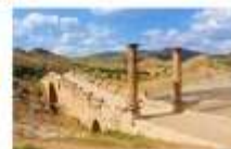
สะพานเซเวอร์วัน
